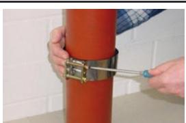
DE Verbinder aufsetzen und mit Schraubwerkzeug wechselseitig gleichmäßig festziehen
