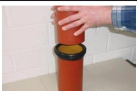
DE Nächstes Rohr- bzw. Formstück bündig auf Distanzring der Manschette aufsetzen
