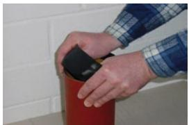
DE Manschette auf Rohrende stecken. Mittlerer Distanzring der Dichtung liegt auf dem Rohr auf
