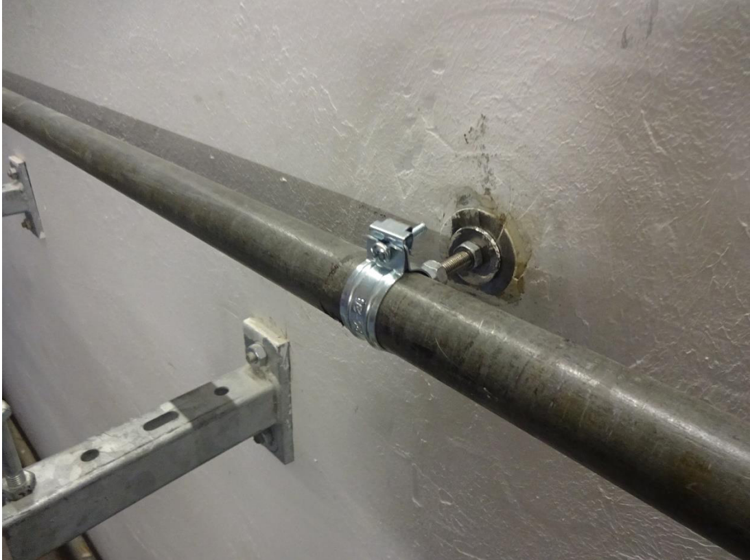
Bild 1: Bezugsmessung: OPTIMAL JUNIOR EASY, 1" (26 - 28 mm), Anschluss M8, starrer Anschluss
