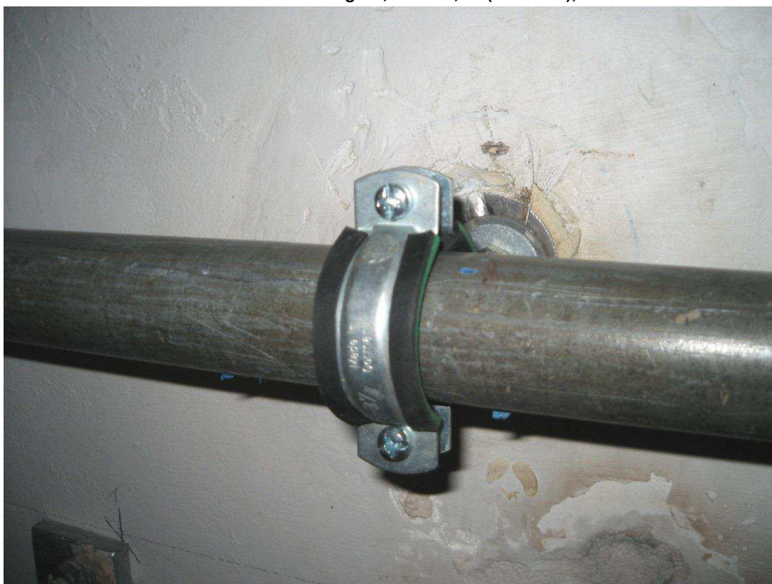
Bild 2: Schraubroherschelle JUNIOR DÄMMGULAST® grün, M8/M10, 1" (33-37mm), verzinkt
